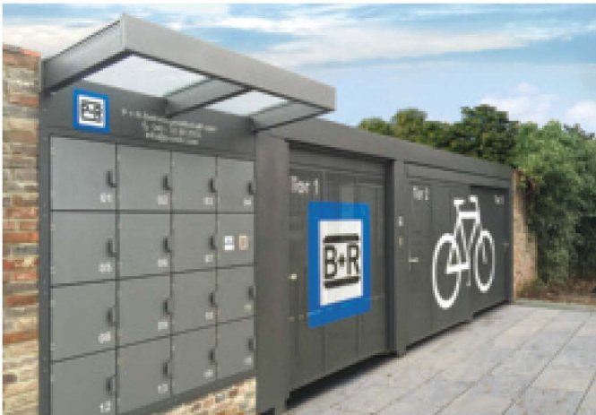
Die gesicherten Fahrradabstellplätze wurden durch eine mit Lochblechfasade verkleidete Sammelschließanlage in eine Bestandsmauer integriert.
