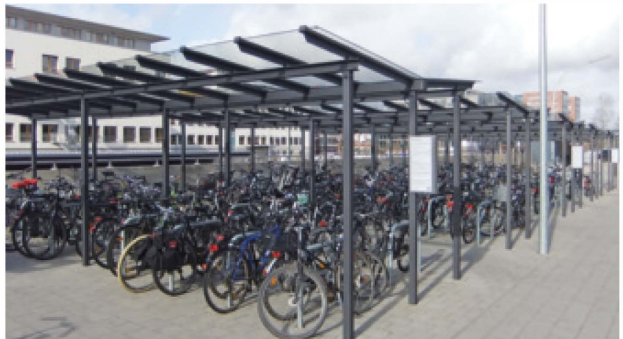
Die neuen Überdachungen sorgen für zahlreiche wettergeschützte Fahrradabstellmöglichkeiten an der S-Bahn-Haltestelle Poppenbüttel.
