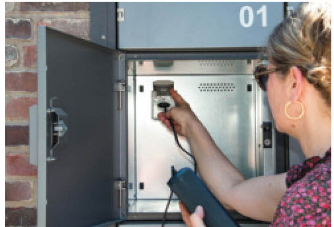
Die in den Mietschließfächern integrierte Steckdose ermöglicht das einfache Laden der Akkus von E-Bikes und Pedelecs.
