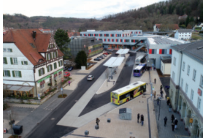
Der neu gestaltete und fahrgastfreundlichere Busbahnhof hat insgesamt sieben Haltestellen. Vier davon in Sägezahn-Anordnung entlang der Arkaden.
