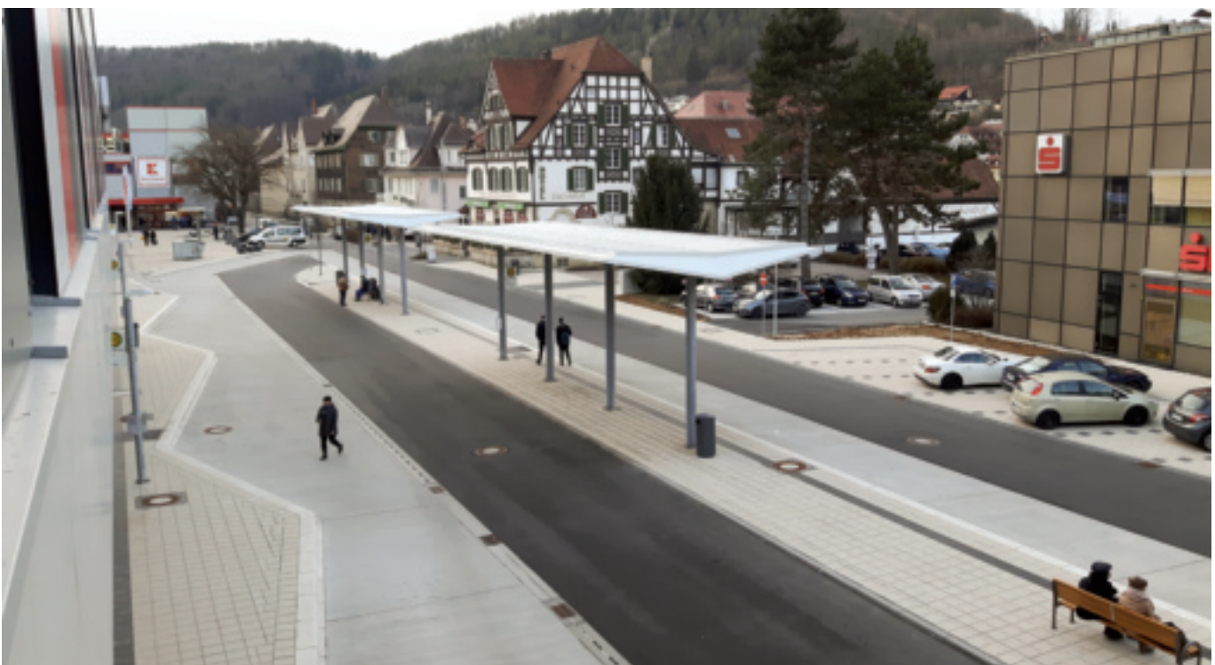
An der 4 m breiten und 77 m langen Mittelinsel können je nach Bedarf drei Gelenkbusse oder vier normale Busse gleichzeitig halten.
