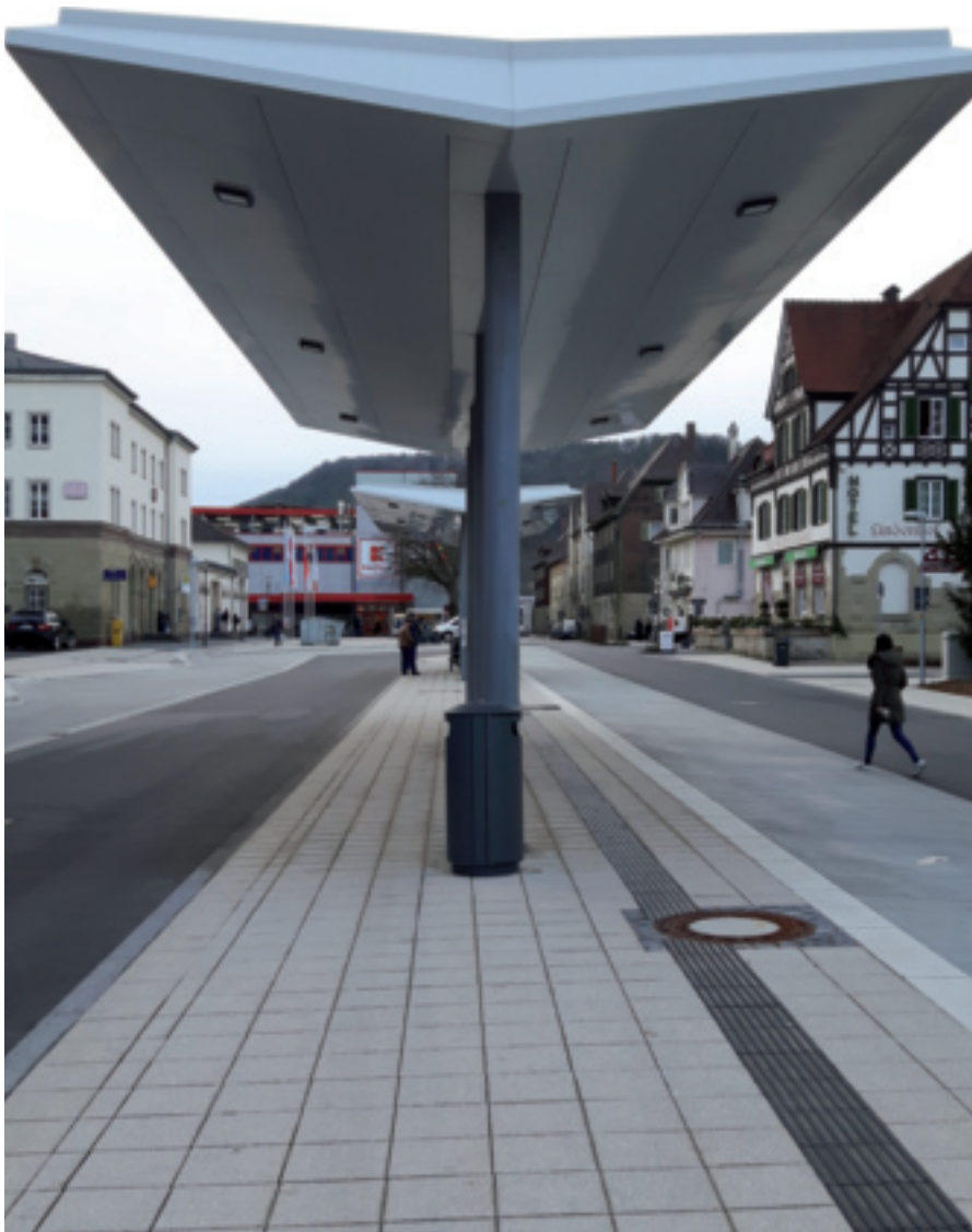
Die neuen Bahnhofüberdachungen sind jeweils 5 m breit, 18 m lang und ragen 4,5 m in die Höhe. Wichtig war, dass die Fahrgäste im Trockenen ein- und aussteigen können.
