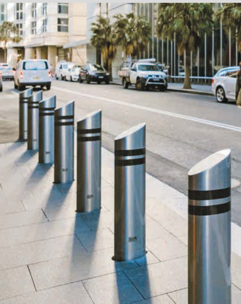
Fixe Hochsicherheitspoller mit Edelstahl-Ummantelung, Aufprallresistenz 7,5 Tonnenschwerer Fahrzeuge bei 48 km/h
