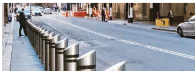
Fixe Hochsicherheitspoller mit Edelstahl-Ummantelung, Aufprallresistenz 7,5 Tonnenschwerer Fahrzeuge bei 48 km/h
